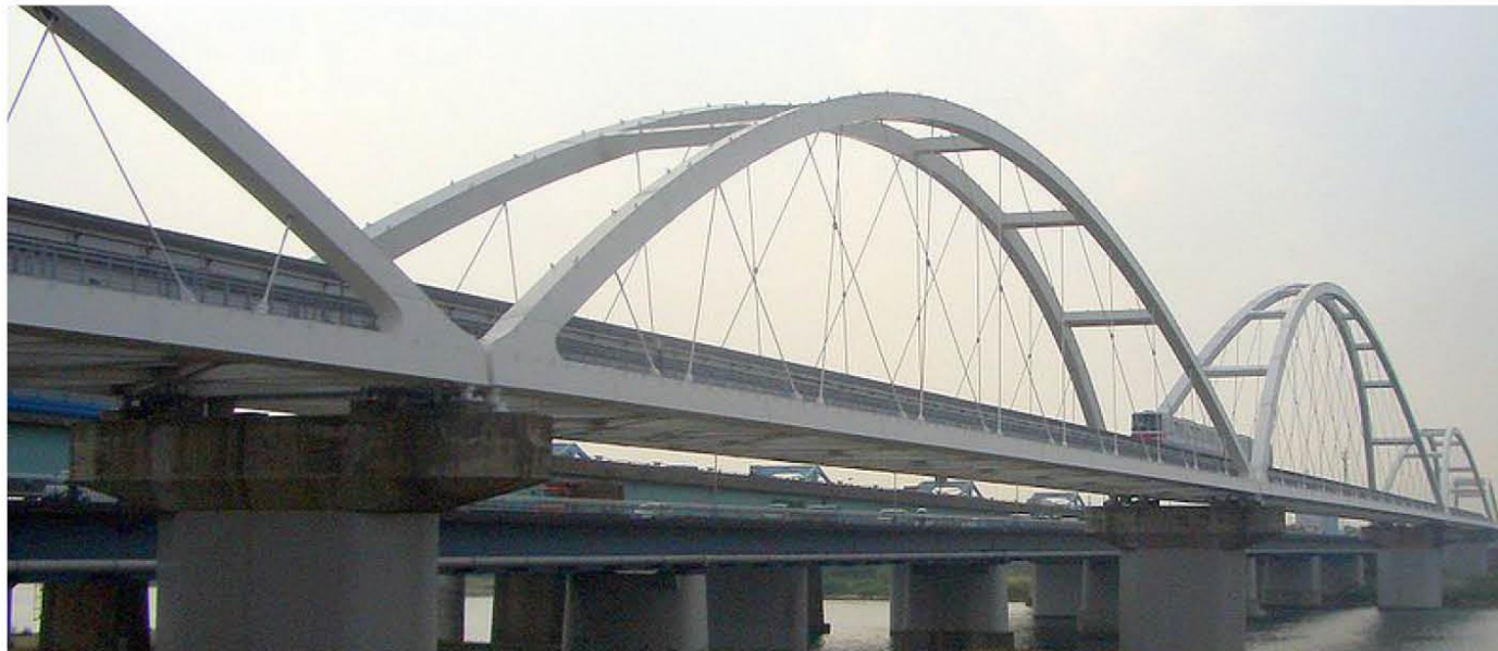
Torikai Ohashi Bridge, Osaka, Japan
